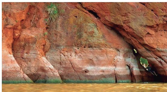
Figura 7. Las cavernas marinas son la evidencia más clara de socavamiento. Se excavan a lo largo de zonas de debilidad de todo tipo, y en especial allí donde las rocas están muy divididas por diaclasas (Holmes, 1978). En la imagen se observa la pequeña caverna desarrollada a partir del socavamiento en zona de fractura en el acantilado de Itá Pytã Punta (imagen por gentileza de Ron Halliday).
